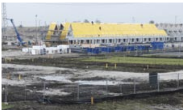
Baanhoek West is in aanbouw.
