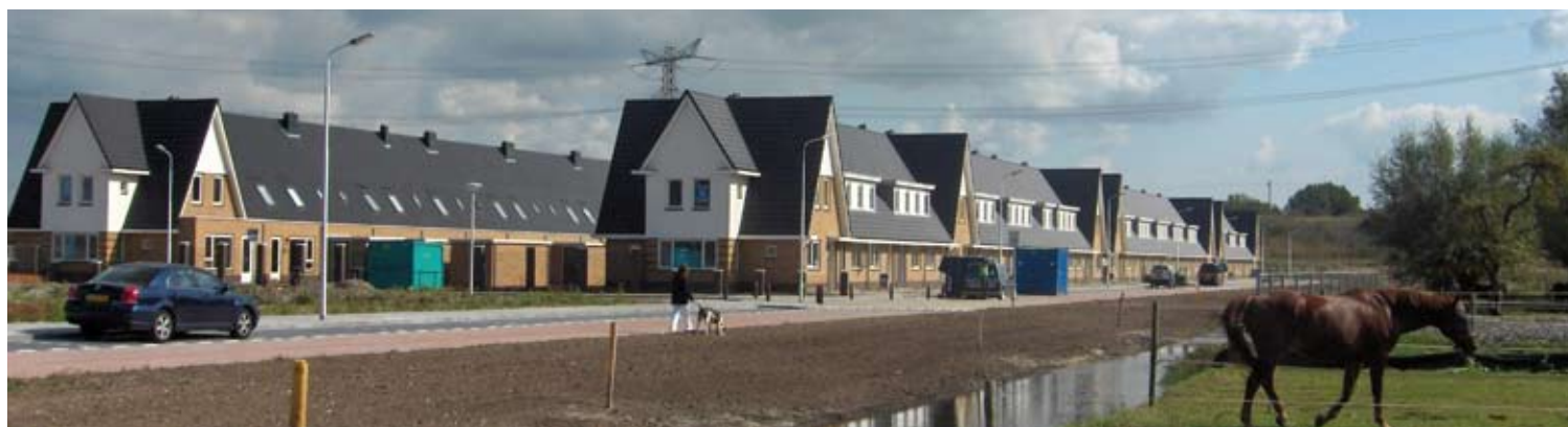
De eerste woningen in Baanhoek West.
