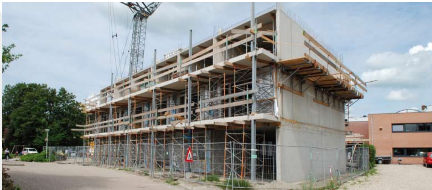
Appartementencomplex De Gantel in aanbouw.
