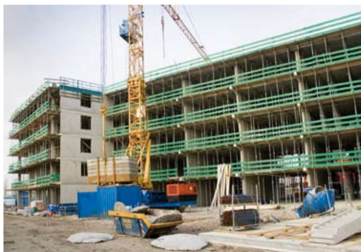
De Blauwe Lis (Baanhoek West) in aanbouw.
