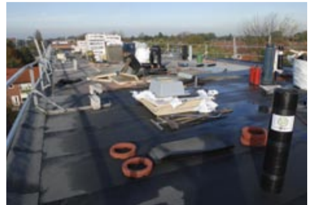
Het aanbrengen van het gerecyclede materiaal.
