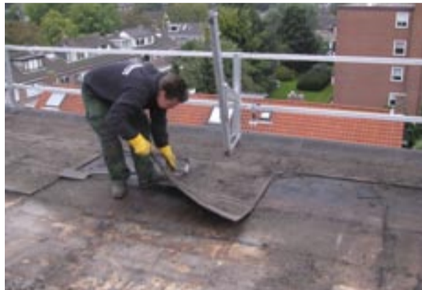
De verwijdering van de oude dakbedekking.
