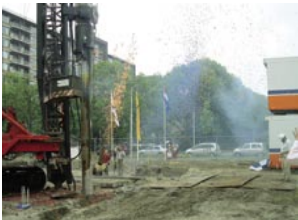
De eerste paal voor de nieuwe Hooghe Dijk.
