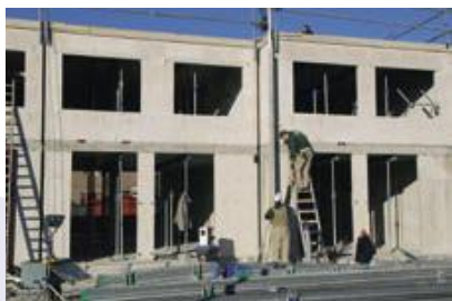
De bouw aan de Ruysdaelstraat is in volle gang.
